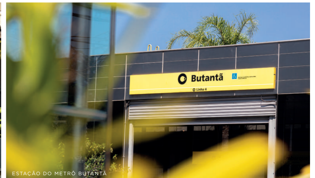
ESTAÇÃO DO METRÔ BUTANTÃ
