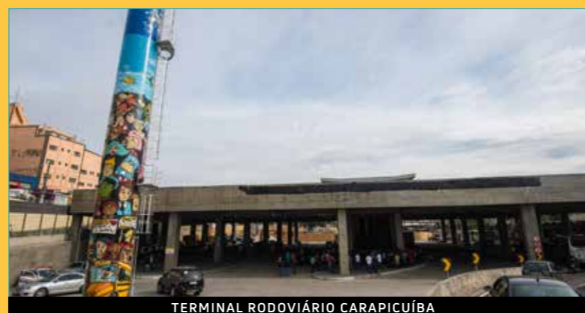
TERMINAL RODOVIÁRIO CARAPICUÍBA
