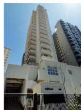
Edifício Camburi Jabaquara
