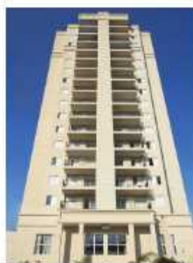
Edifício Authentic Adimogão
