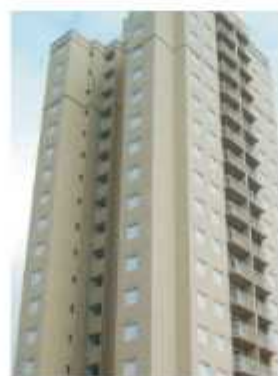
Edifício Camborã Penha
