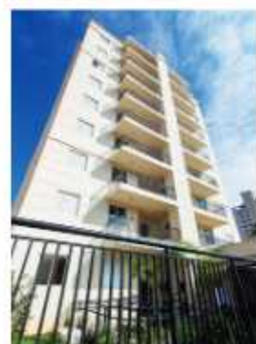
Edifício Giro Ipiranga
