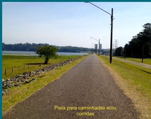
Parque Linear da Barragem Guarapiranga
