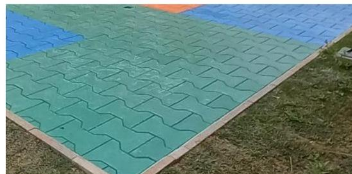
PISO EMBORRACHADO HIAIAH TIPO "I", NA COR VERDE
