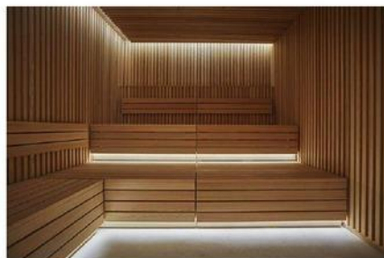
ILUMINAÇÃO EM BAIXO DO BANCO E NO PERIMETRO DO TETO - CONSULTAR FORNECEDOR ESPECIALIZADO
