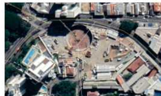
Obras da futura estação Vila Formosa
